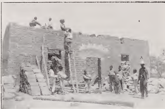
CONSTRUCCIÓN DEL EDIFICIO DE LA ESCUELA RURAL FEDERAL DE SALERO, S. L. P.
